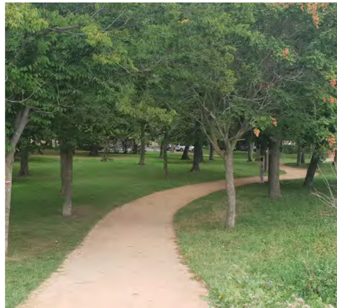
Cheminement existant - Stabilisé (récent)
