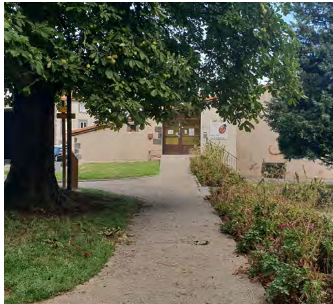
Cheminement existant - Béton désactivé
